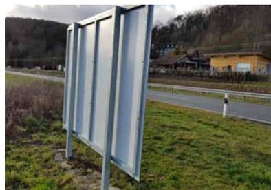
Stahlträgerelement für das „große Baustellenschild“ in Gräfendorf
